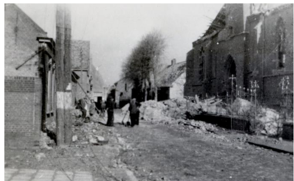
Figuur 1 De opgeblazen toren ligt op straat - archief Heemkring Molenheide
