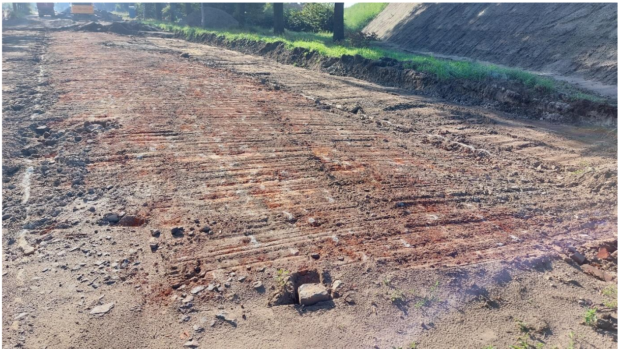
Foto richting het oosten, in het verlengde van de weg. Aan weerszijden zijn kalkstenen insluitbanden te zien. De bolling van de weg is op deze foto ook goed waarneembaar. Middenin kleurt het wegdek rood, vanwege puinfragmenten tussen de natuurstenen kasseien.
