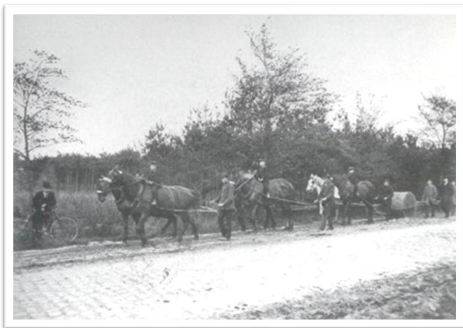
Paardentrekwaals bij de aanleg van het rijwielpad langs den rijkskeiweg Tilburg-Breda in 1902
