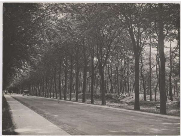
Rijksweg Breda - Tilburg tussen Rijen en Molenschot na 1930 met asfaltbetonnen wegdek en betonnen fietspad. Foto: collectie gem. Gilze en Rijen.
