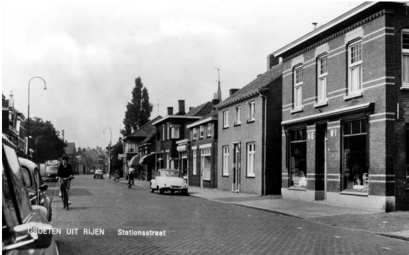
Kantoorboekhandel VEWI (ca. 1960), huidige locatie van het centrum-oost in aanbouw (beeldarchief Heemkring Molenheide)
