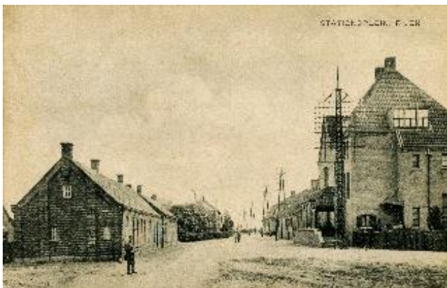
Het Stationsplein in Rijen met bovengrondse stroomvoorziening
