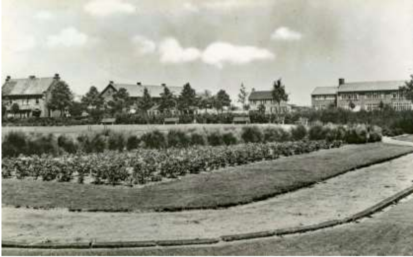
Het parkgedeelte van het Burgemeester Sweensplein, 1956
