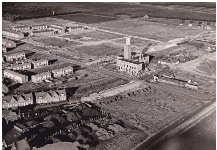
Uitbreidingswijk 'Vijf Eiken' in Rijen in aanbouw, ca 1960
